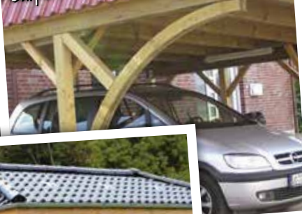
Carport mit Leimholzbogen
